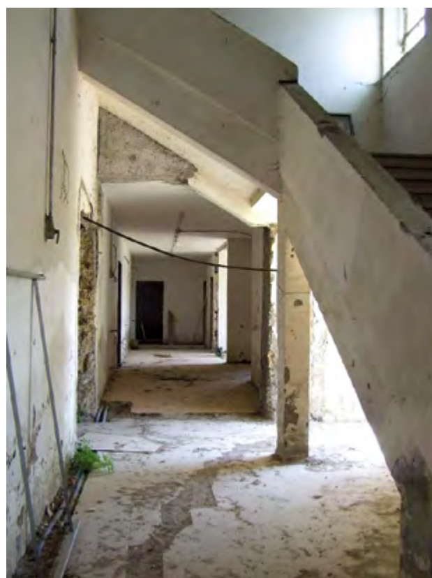
Fig. 42 - Situazione dell'ex Cinema dopo l'interruzione dei lavori del 2004. Scala che conduce alla Galleria.
