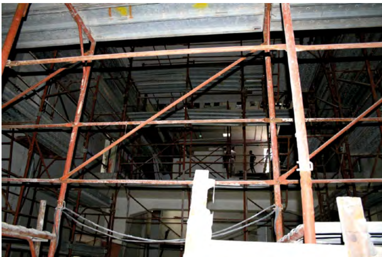
Fig. 44 - Salone dell'ex Cinema durante i lavori ripresi nel 2014.
