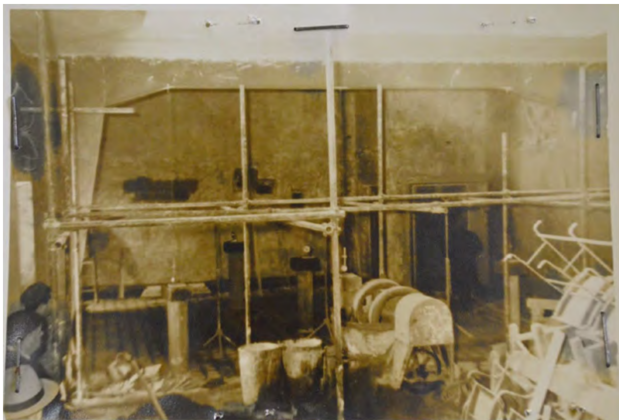
Fig. 29 bis – febbraio 1961 - A.S.Vt, Fondo Prefettura – Calcoli cemento armato. B. 2 fasc. 48 - Caprarola (Aut. Min. n. 100-A del 17.01.2019). Platea del Cinema durante i lavori.
