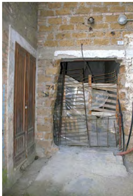
Fig. 16 - Ingresso secondario ed uscita di sicurezza del Cinema durante i lavori di ristrutturazione.
