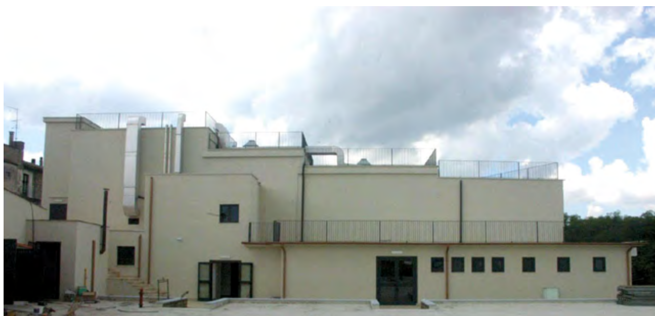
Fig. 47 bis - Veduta esterna dell'ex Cinema a lavori ultimati nel 2019.
