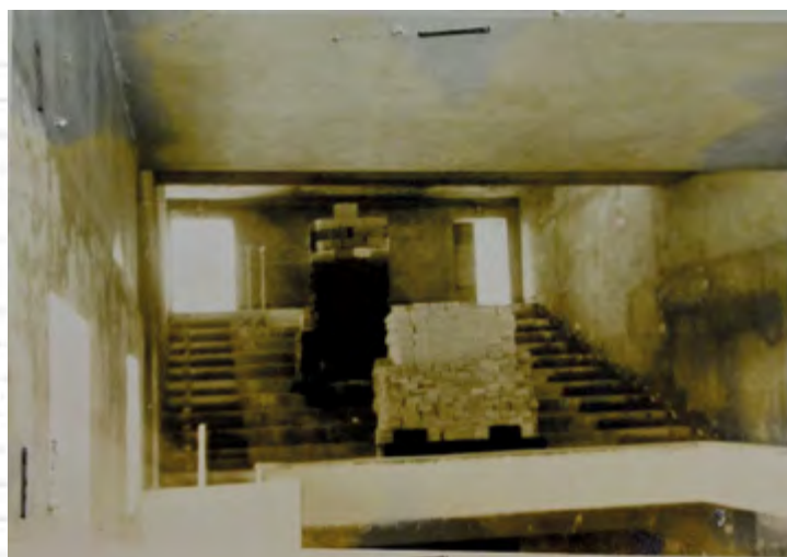
Fig. 27 - febbraio 1961 - A.S.Vt, Fondo Prefettura - Calcoli cemento armato. B. 2 fasc. 48 - Caprarola (Aut. Min. n. 100-A del 17.01.2019). La Galleria del Cinema durante le prove di carico.
